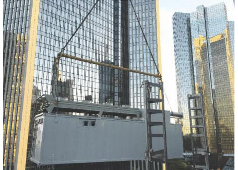
Spektakulärer Einsatz am Commerzbank-Tower, mit 259 Metern Deutschlands höchstem Hochhaus: Ein Mobilkran befördert das Notstromaggregat der Overather Lindenberg-Anlagen GmbH auf das Dach des Gebäudes. (Foto: Lindenberg)
